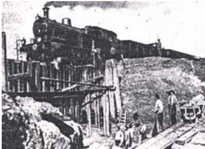
Bron 8 De trein naar Hoorn passeert het viaduct in aanbouw over de provinciale weg (1937).
