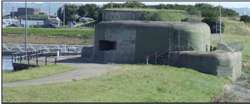
Bron 20 De kazematten, een ouderwets woord voor bunkers, van Kornwerderzand.
