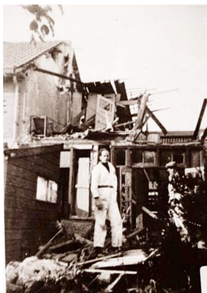
Bron 64 Schade na het bombardement.
