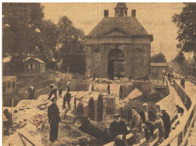
Bron 7 De Koepoort. In 1937 werd de brug die er nu ligt gebouwd.
